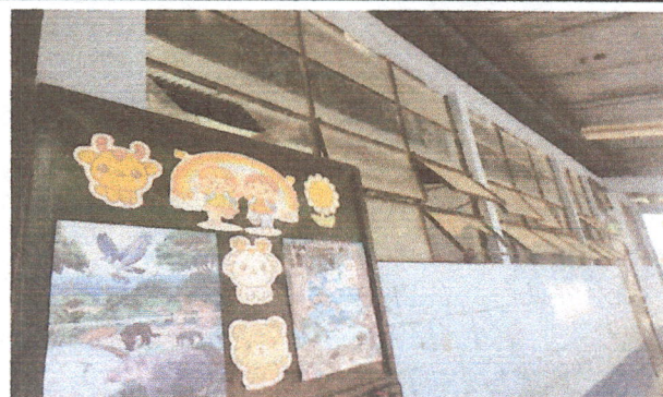
FOTOGRAFIA 4: REPARACIÓN DE DE VENTANAS
