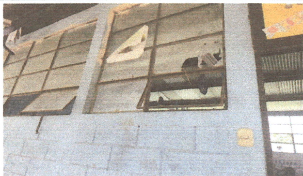
FOTOGRAFIA 3: REPARACIÓN DE VENTANAS
